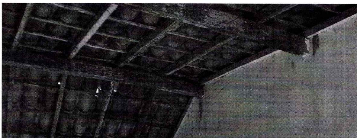
Figura 4: TRAMAS DE MADEIRA COM PRESENÇA DE CUPINS
