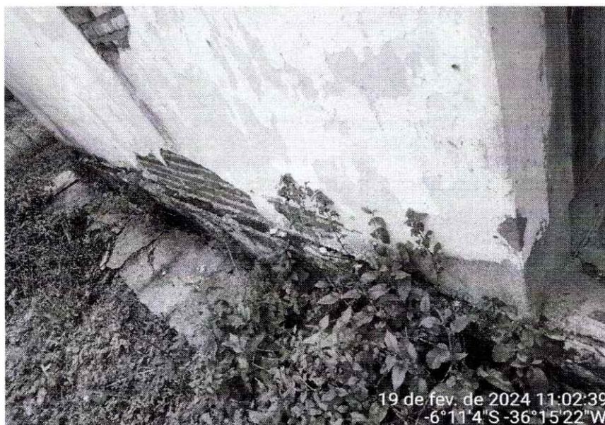
Figura 5: DESPLACAMENTO DE REBOCO
